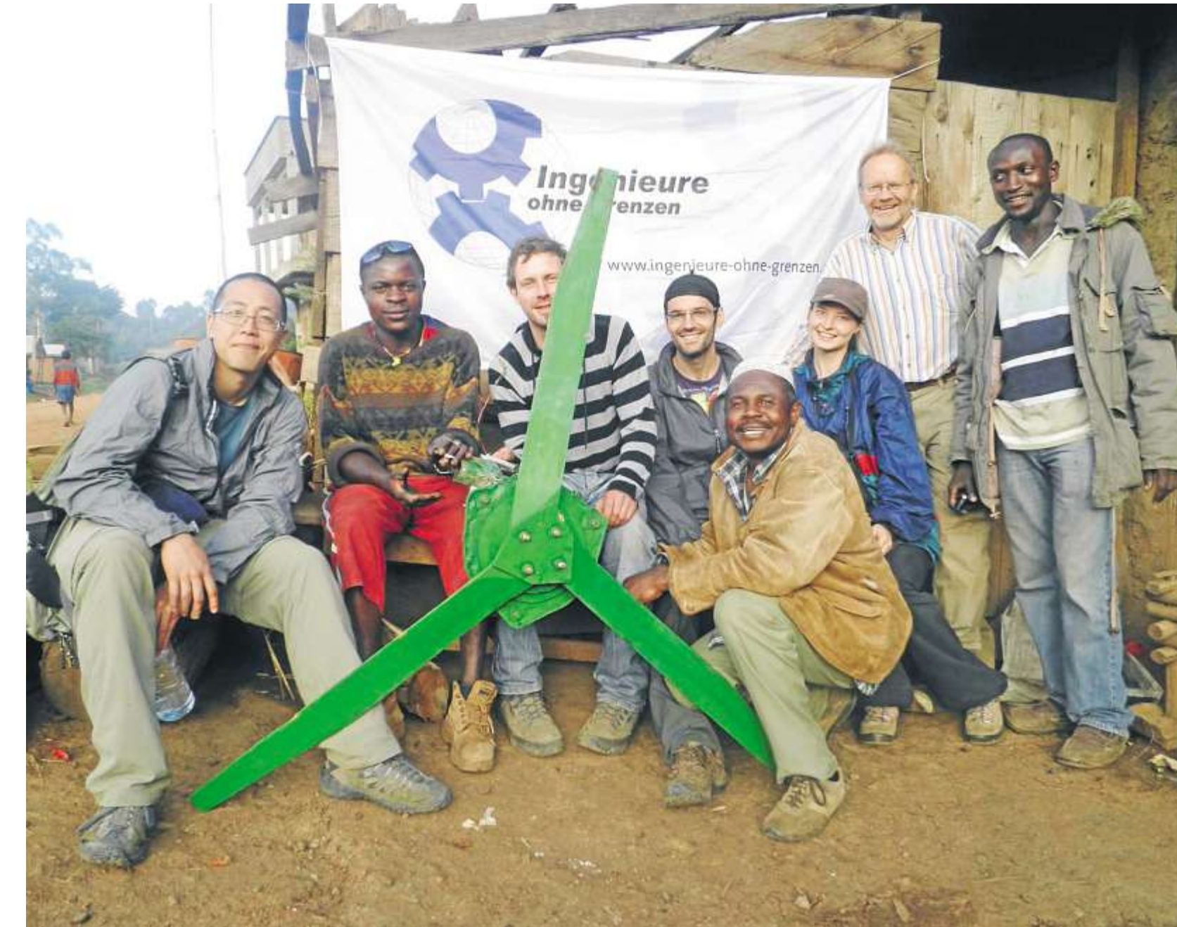
Auf der Durchreise reparierte das Team von Ingenieure ohne Grenzen und Green Step spontan eine alte Windkraftanlage. Bryan Ho-Yan, Björn Pucher, Johannes Hertlein, Petra Kürzinger und Stefan Krebs (von links) freuen sich, den Kamerunern bald noch mehr helfen zu können. Fotos: Ingenieure ohne Grenzen
